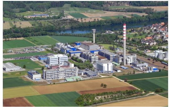
Arbeiten Vorzugsgebiet Spitzentechnologie Sisslerfeld
