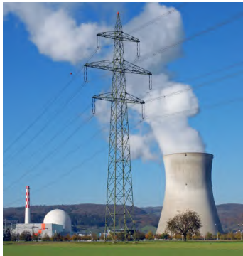
Versorgung Energieproduktion und Leitungen
