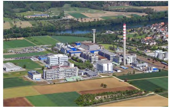
Arbeiten Vorzugsgebiet Spitzentechnologie Sisslerfeld
