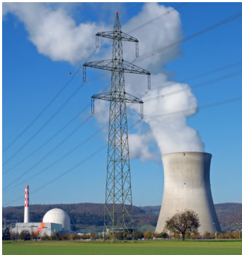
Versorgung Energieproduktion und Leitungen
