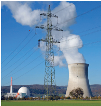
Versorgung Energieproduktion und Leitungen
