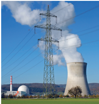
Versorgung Energieproduktion und Leitungen
