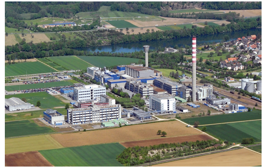
Arbeiten Vorzugsgebiet Spitzentechnologie Sisslerfeld
